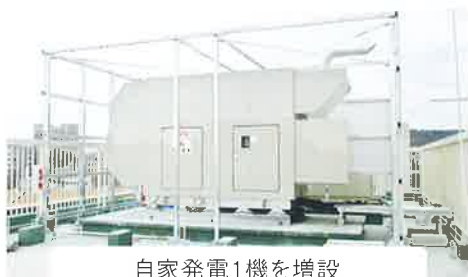
自家発電1機を増設
